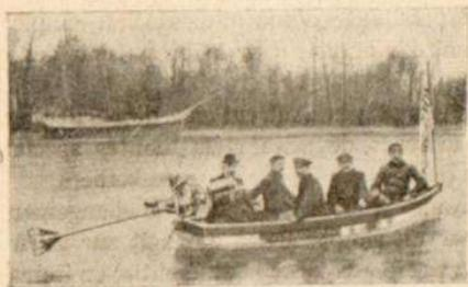
FIG. 240. — Canot équipé avec une moto-godille.
